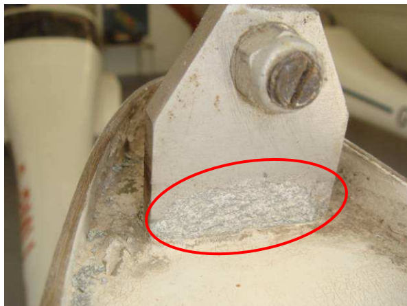
Fig. / Abb. 2 Corroded nose plate Korrodierte Nasenplatte
